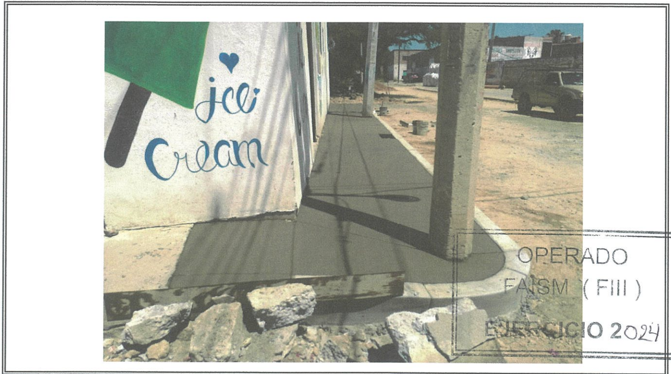
CONSTRUCCION DE PAVIMENTACION EN LA CALLE CAMPO DEPORTIVO DE LA ZONA ZAP 0371 DE LA LOCALIDAD DE NOCHISTLAN, MUNICIPIO DE NOCHISTLAN DE MEJIA ZACATECAS
