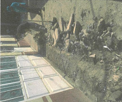
Demolicion de Banqueta concreto simple de 10cm de espesor prometido con muelles mecánicos incluye acarreo de material al sitio de acopio y fraspaleos
