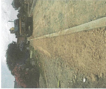
Mezclado tendido y compactacion de la construccion de base para banquetas compactada con ballarina al 100%, utilizando material de banco (topolote)
